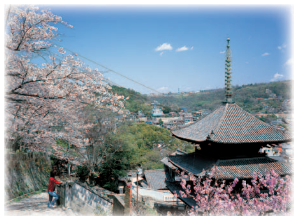
桜の頃の天寧寺三重ノ塔。
